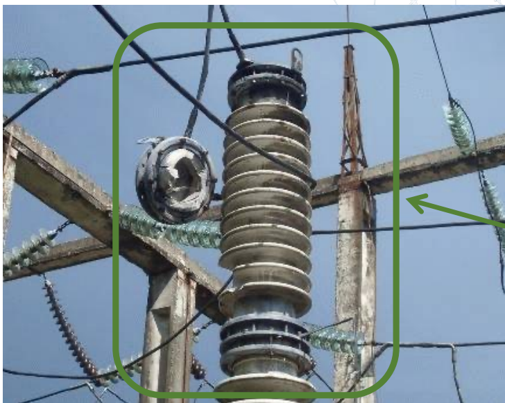
Bucha de Subestação e Pára Raios Danificados
