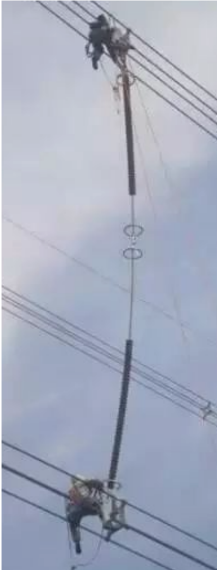
Figura C.3 Diagrama esquemático da combinação de hastes isolantes espaçadoras entre fases e espaçador amortecedor de pêndulo duplo
