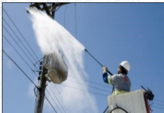
Figura: Aplicação da solução por jateamento em suspensão em superfície e aplicação da solução por jateamento em linha viva.
