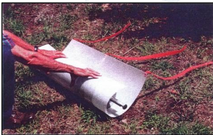
Figura: Alternativas de métodos corretos de reembalagem dos isoladores compostos para transporte em obra.
