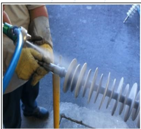
Figura: Aplicação da solução por jateamento em suspensão em superfície e aplicação da solução por jateamento em linha viva.
