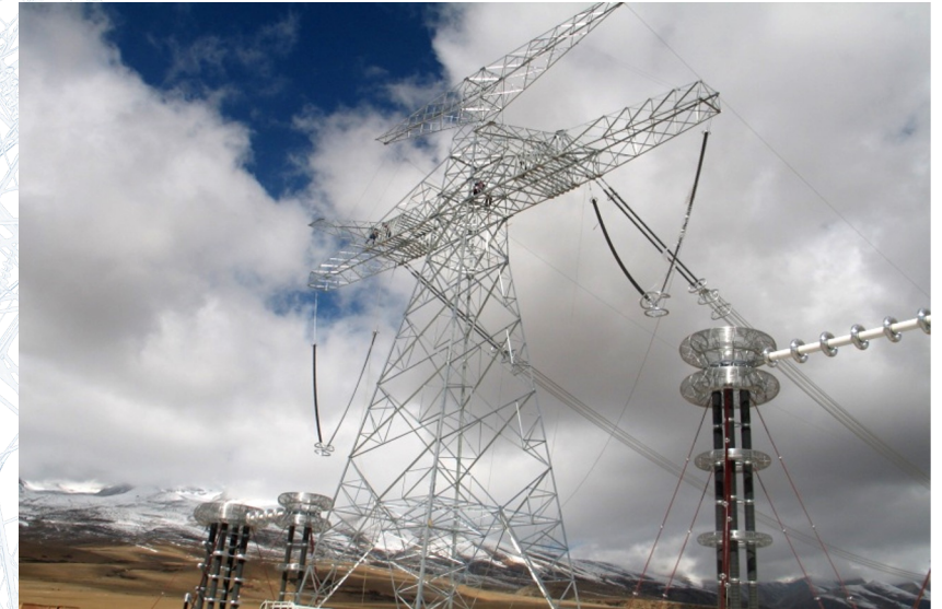
BASE DE TESTES EM ALTITUDE \pm 1000 kV - TIBET A BASE DE TESTES INSTALADA NA MAIOR ALTITUDE POSSÍVEL (4.300m)
