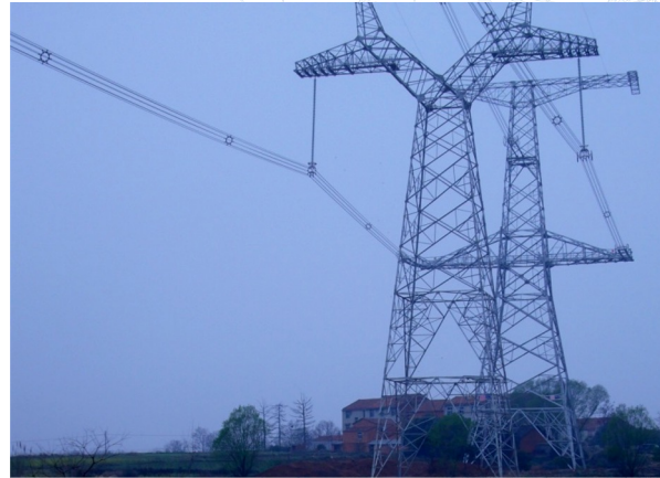
BASE DE TESTES 1000kV AC EPRI - BEIJING
