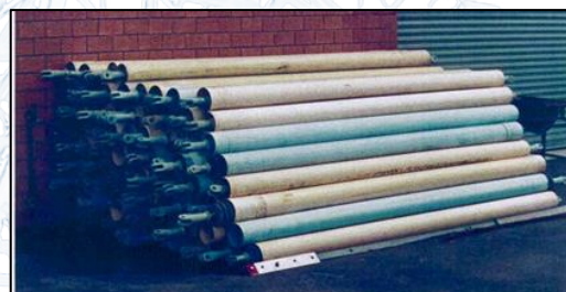
Figura: Alternativas de métodos corretos de reembalagem dos isoladores compostos para transporte em obra.
