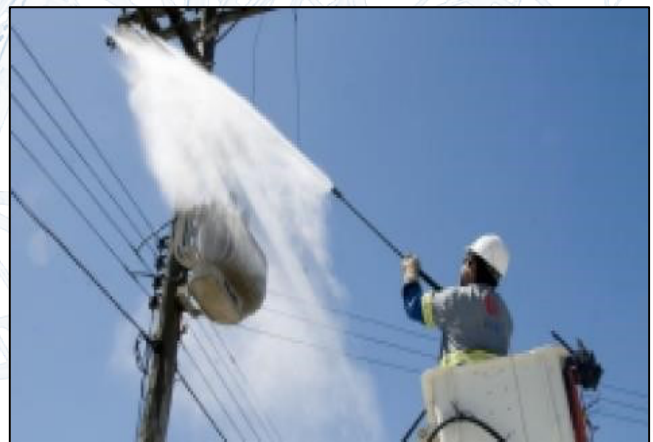
Figura: Aplicação da solução por jateamento em suspensão em superfície e aplicação da solução por jateamento em linha viva.
