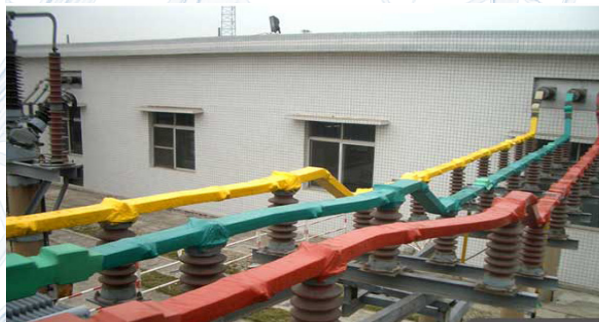
Após a aplicação da fita de autofusão
