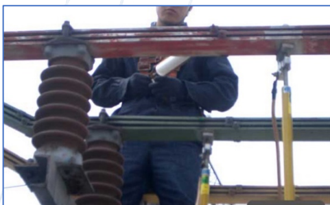
Antes da aplicação da fita de autofusão
