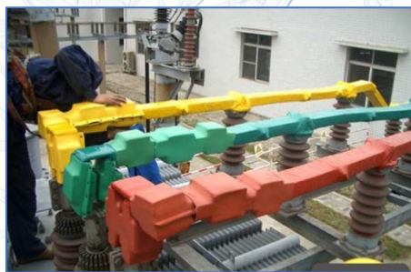
Durante a aplicação da fita de autofusão
